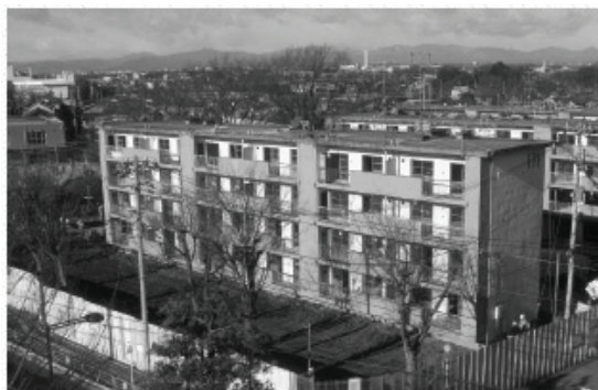
写真1 街区東南部より見る
