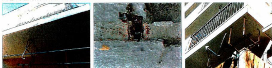
エントランスの集合郵便受箱脇の棚板劣化が目立ちます。表面の塗装剥がれはもとより、反りや板自体がなくなっている箇所も見られます。実際に使用している様子が見られないため、撤去の方が良いかと考えますがいかがでしょうか。
